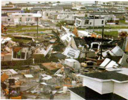
▲ El paso del huracán Dorian por la costa este de los Estados Unidos en septiembre del 2019 dejó grandes destrozos, como puede observarse en este hotel de la ciudad de Carolina del Norte.
